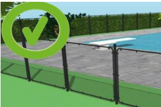
Exemple de clôture de mailles de chaîne dont la largeur est de moins de 30 mm.
